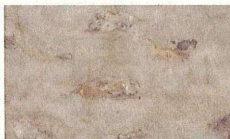
mur enduit « à pierre vue »
